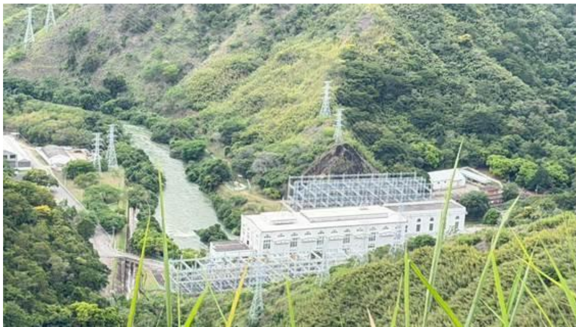
Figura 64. Usinas hidrelétricas do Complexo de Lajes vistas a partir de Ribeirão das Lajes.
