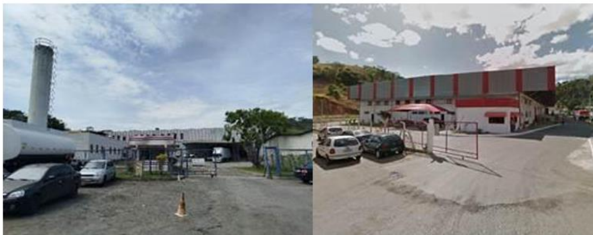
Figura 62. Empresas Disprol Atacadista, Lumade Comercial e Medicamental distribuidora localizadas na Rua 17 de Outubro e voltadas ao comércio atacadista de produtos alimentícios, medicamentos e produtos de limpeza em geral.
