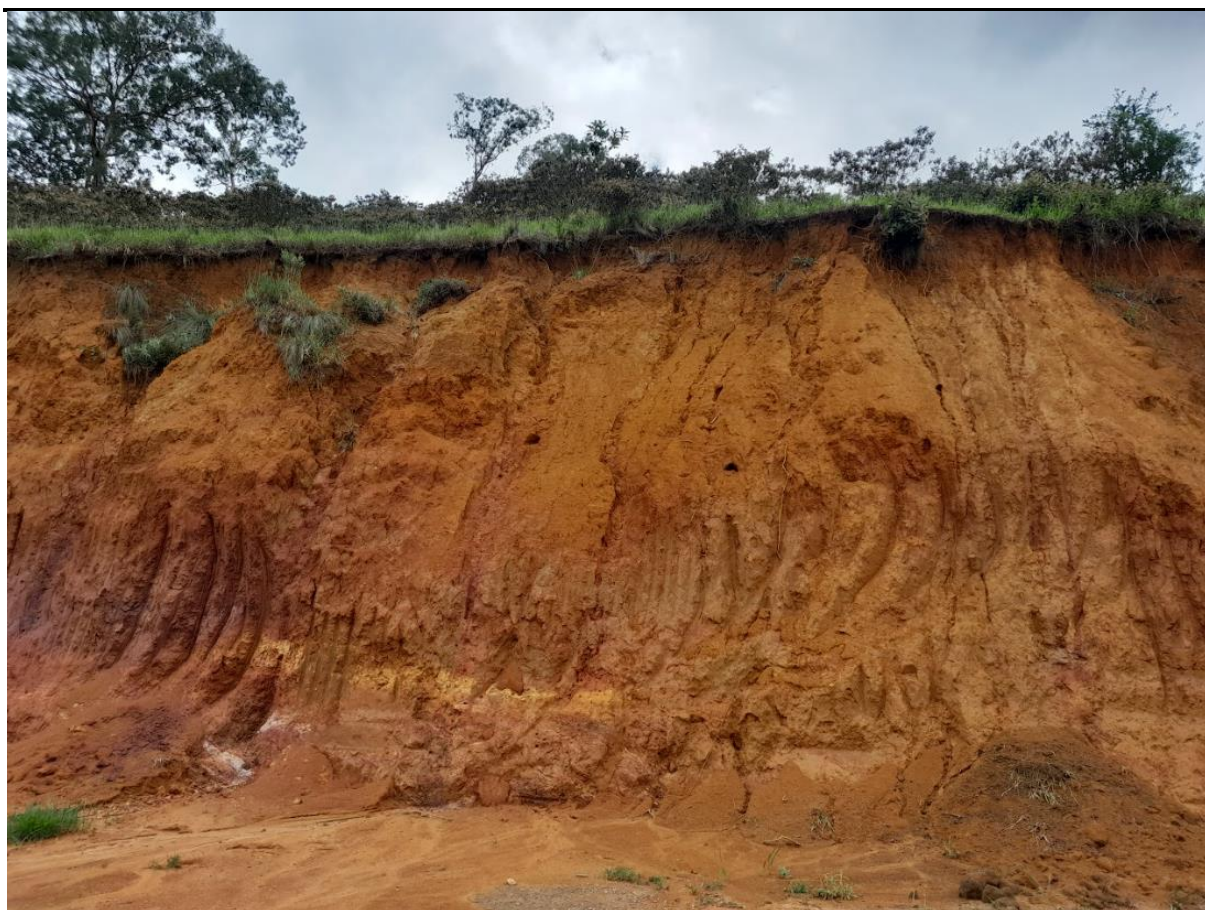
Figura 49. Sulcos erosivos em corte de estrada
