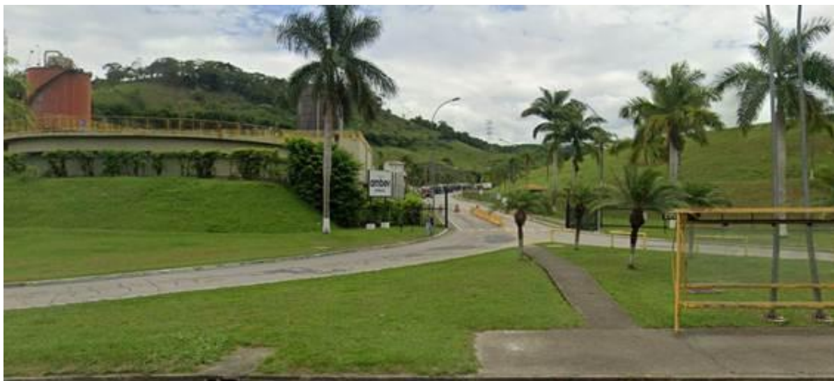
Figura 58. Entrada da Ambev na Rodovia Presidente Dutra, KM 236.
