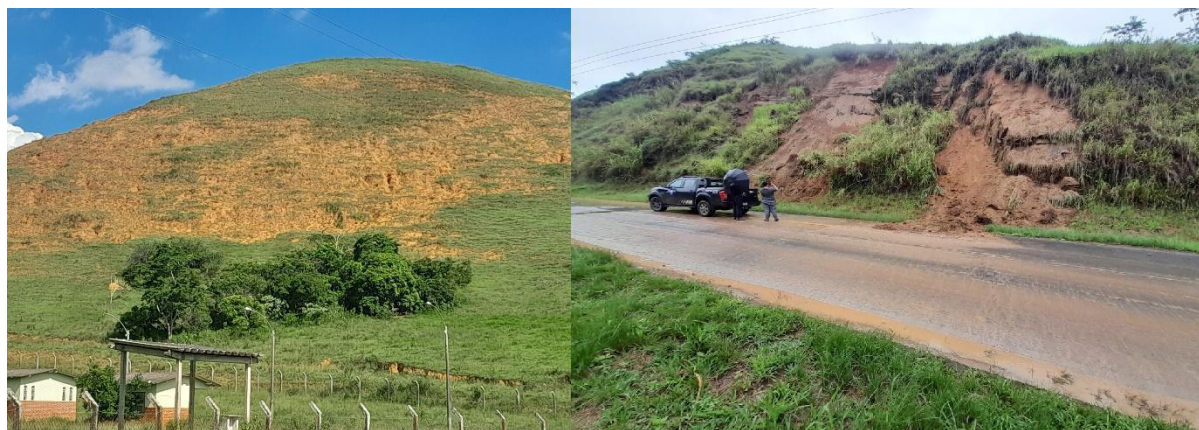
Figura 46. Erosão laminar e sulcos em vertente convexa (à esquerda) e deslizamentos de terra em corte de estrada (à direita).
