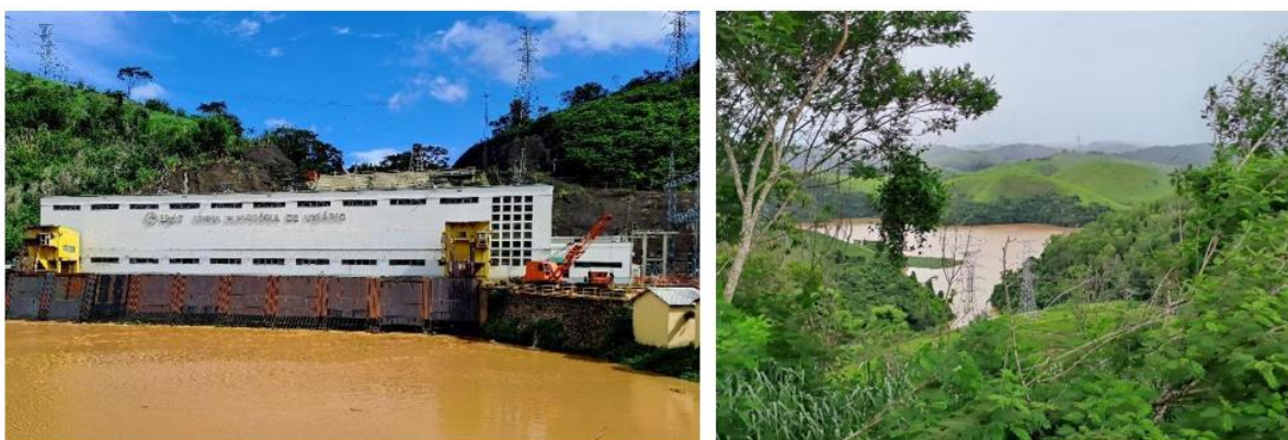
Figura 3. Usina Elevatório de Vigário e linhas de alta tensão da Light
